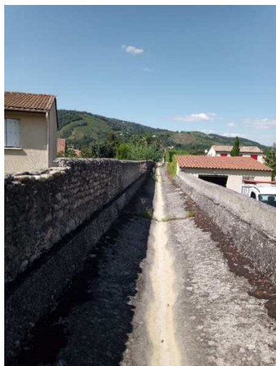
Lit perché du ruisseau de St Just dans un lotissement à Tournon
